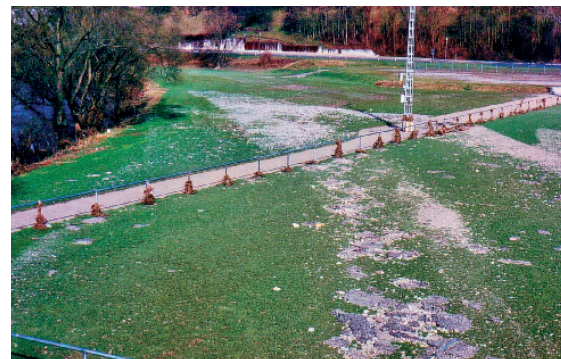
Sportplatz nach dem Hochwasser 1997
