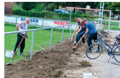
Erneuerung der Banden: Fußballer beim Erdaushub
