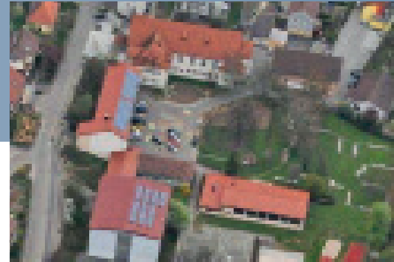
PV-Anlage auf den Schulgebäuden
