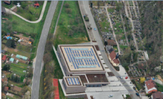
PV-Anlage auf dem Dach der Heinrich-Ehrmann-Halle
